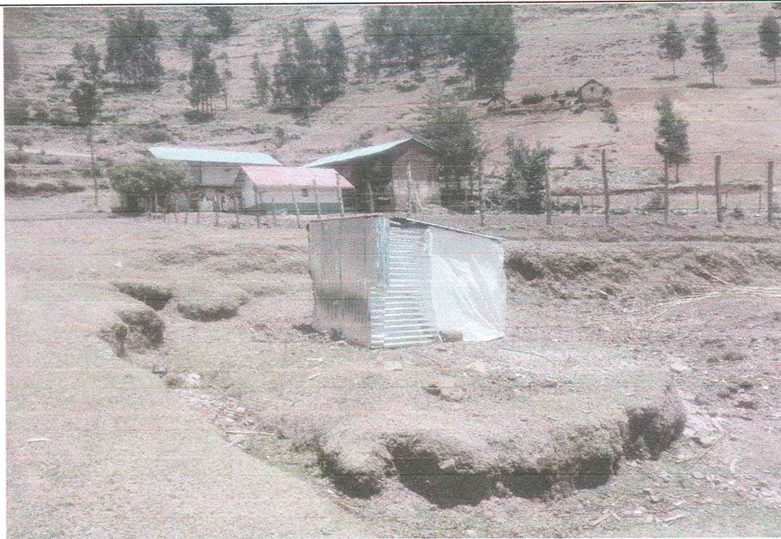
Vista del baño tipo silo provisional con arpillera
